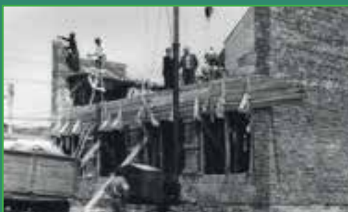
1967 r. Budowa nowej siedziby Banku przy Rynku w Łącku.
