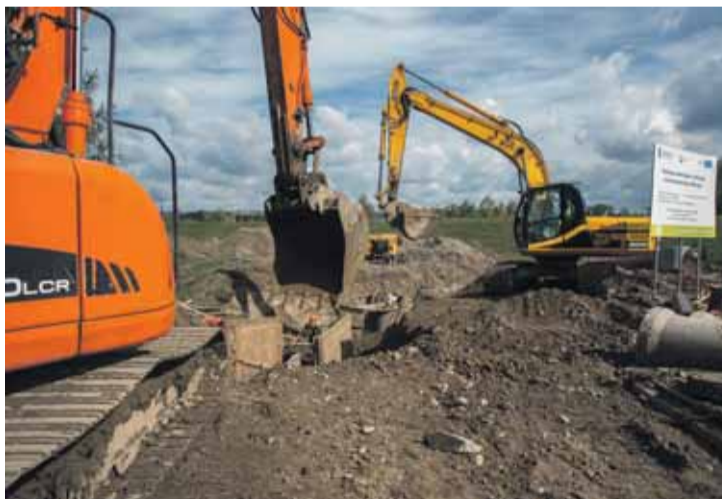
Prace są prowadzone w trudnym, górzystym terenie
