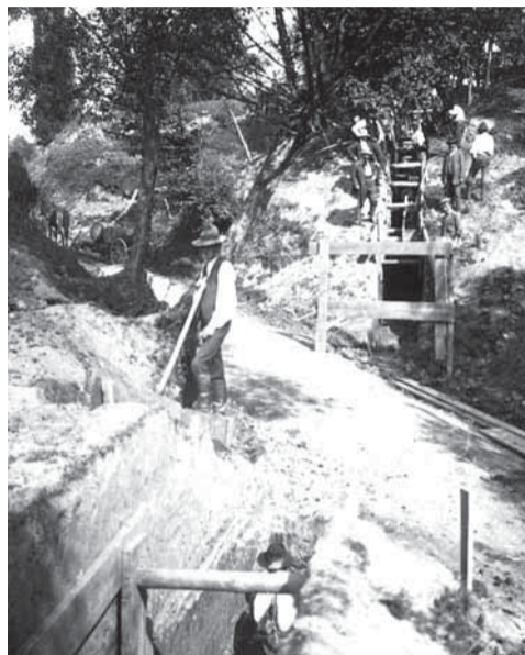
Budowa sieci w regionie Nowego Sącza. Początek XX wieku.
