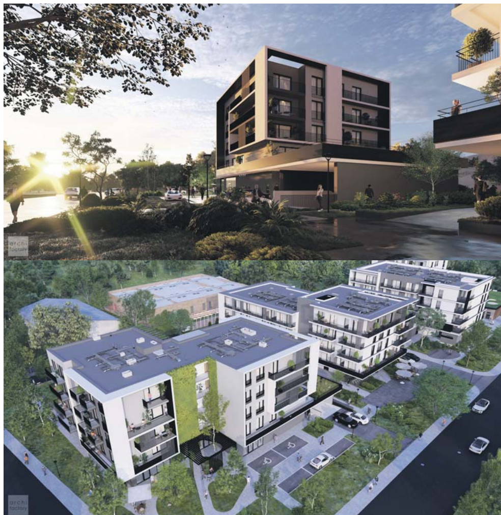
Liczba mieszkańców 38. Obiekt jest w trakcie budowy. Planowany termin oddania do użytkowania to pierwsza połowa 2025 r. W obiekcie zastosowano szereg nowoczesnych rozwiązań w tym ogrzewanie i chłodzenie sufitowe, pompy ciepła, odnawialne źródła energii system hybrydowego ogrzewania z użyciem ciepła systemowego, rozważany jest magazyn energii. W budynku będzie apteka oraz garaż podziemny.
