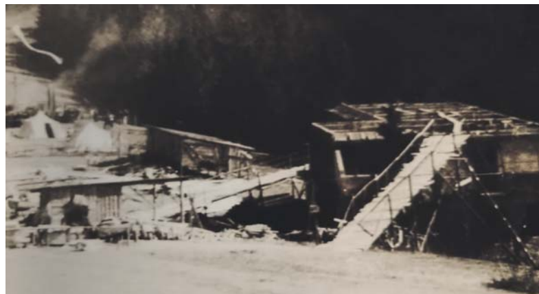
Na zdjęciu budowa schroniska na Przehybie
